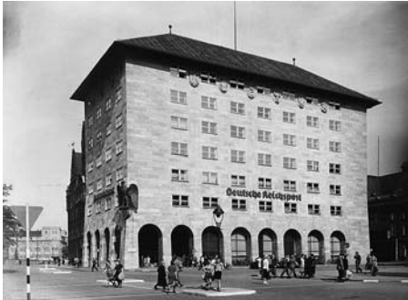
Oben: Der heutige Sitz der Hauptverwaltung der PSD Bank Nürnberg eG am Willy-Brandt-Platz 8 in Nürnberg. Unten: Das Gebäude der Deutschen Reichspost in Nürnberg am Bahnhofplatz 1, wo die „Selbsthilfeeinrichtung“ zu Anfang untergebracht war.
